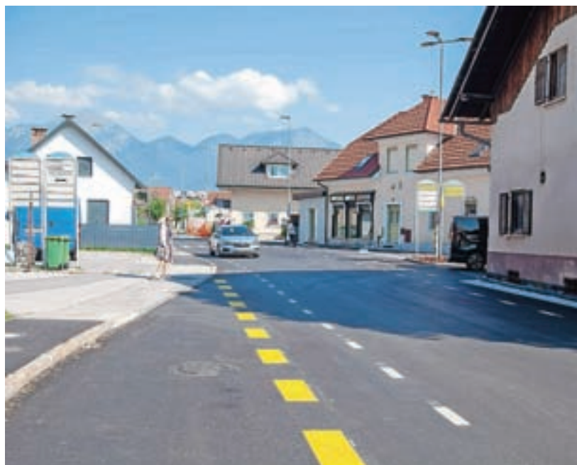
Gasilska cesta po zaključenih delih
